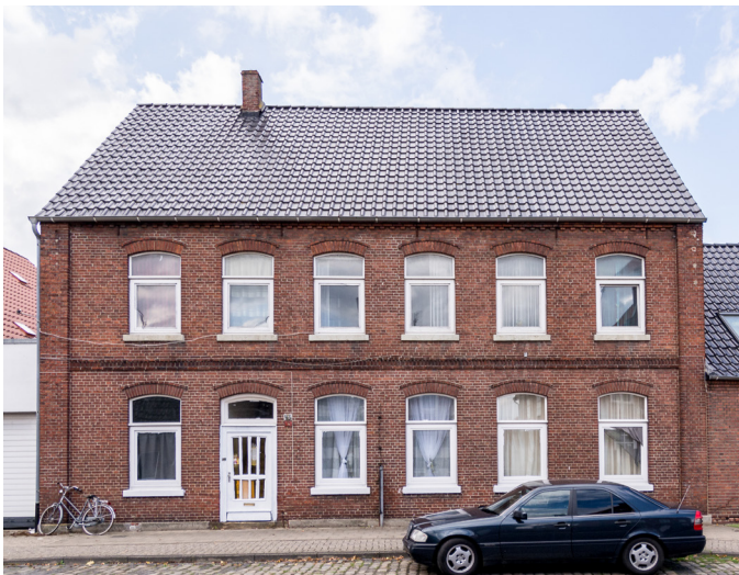
Ehemaliges Haus Süskind, Neuenhaus, Veldhausener Str. 43 (früher Bahnhofstr. 30), im September 2017. Foto: H. Dudeck
